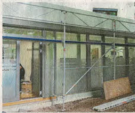
Der Verbindungsbaus, der in der Spreuergasse geschaffen wurde.
